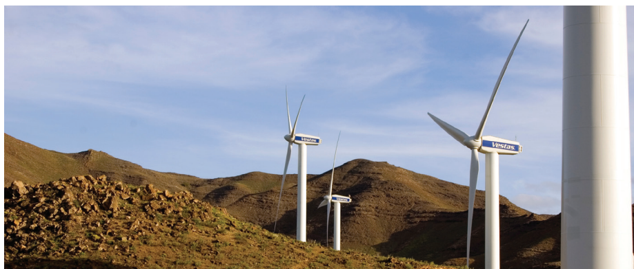
CABEOLICA Parc Éolien de São Vicente, Cabo Verde
