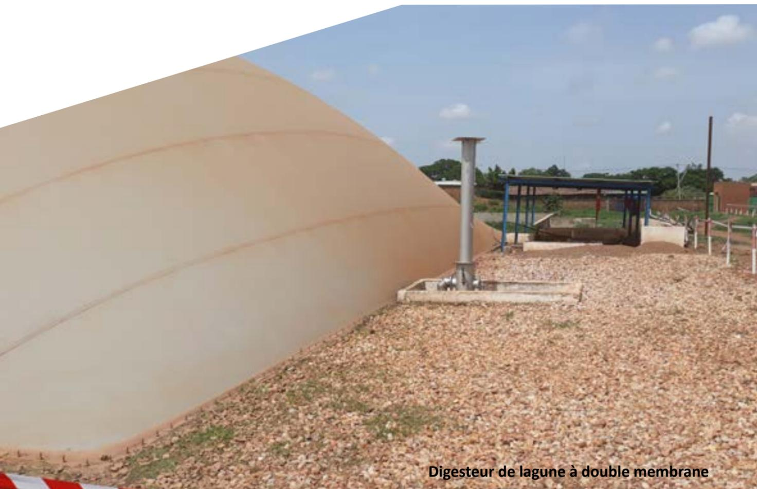
Digesteur de lagune à double membrane
